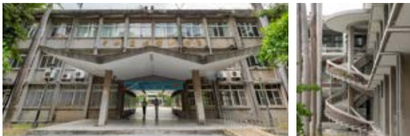
▲ 北向門廊、穿廊與 W 形折板雨庇
