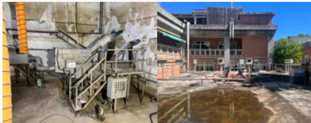
▲ 第一校區污水處理廠
