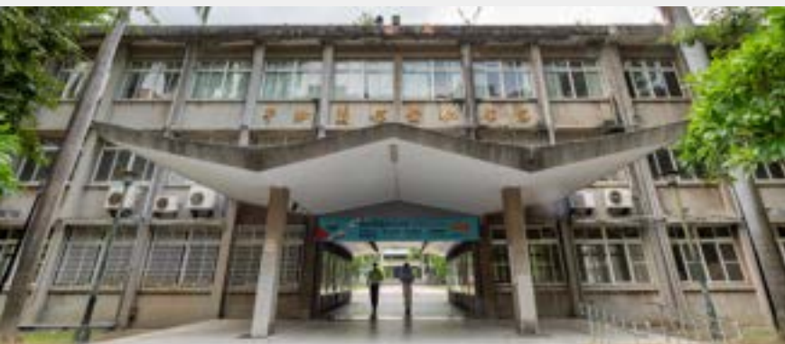
▲ 北向門廊、穿廊與 W 形折版雨庇
